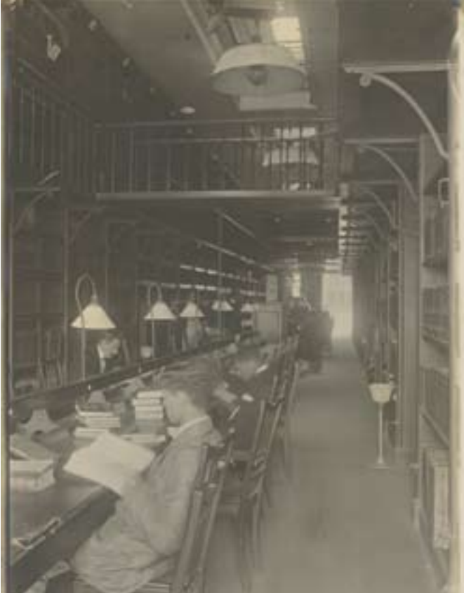
A sala de leitura do antigo prédio da BN, na rua do Passeio ( Imagem 122 )
