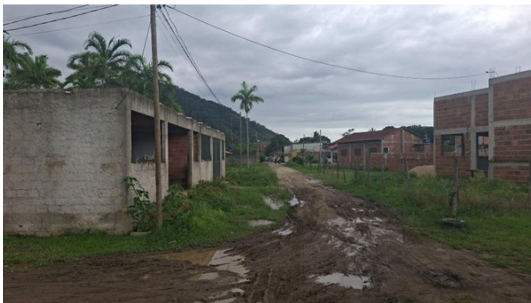
Visualização da área rural com vias sem pavimentação e novos imóveis sendo erguidos
