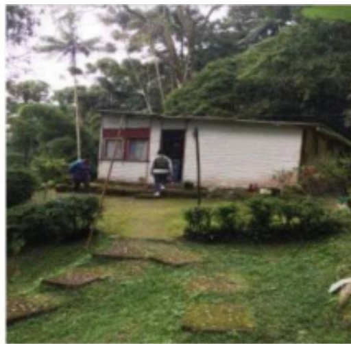
Figura 10. Casa do caseiro.
