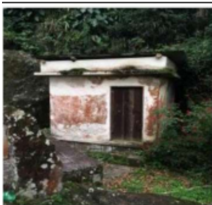
Figura 8. Casa do caseiro
