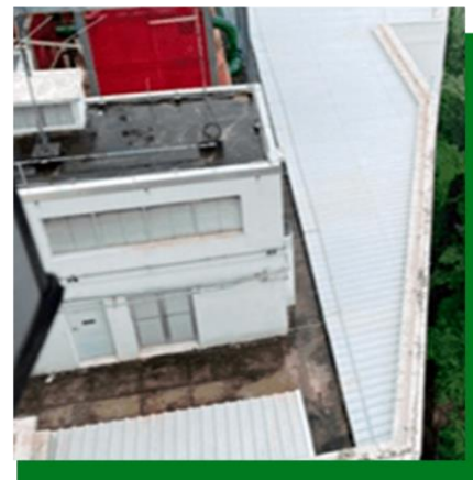
Substituição das telhas de amianto por telhas termoacústicas dos telhados do TRF2
