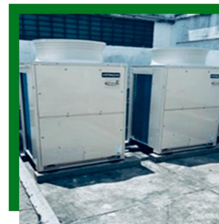
Substituição dos equipamentos de ar condicionado de menor eficiência energética na sede da SJES
